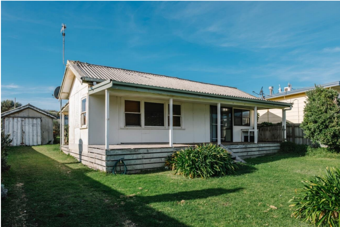
ภาพที่ 1 ภาพถ่ายมุมกว้างให้เห็นสภาพโดยรวมของบ้าน
